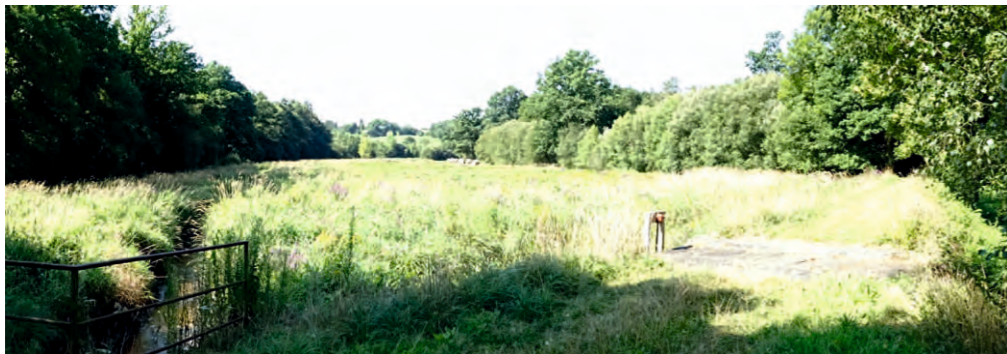
vue vers le sud depuis la digue servant de chaussée ; vannage du bief (à gauche) et vannage du trop-plein (à droite)
