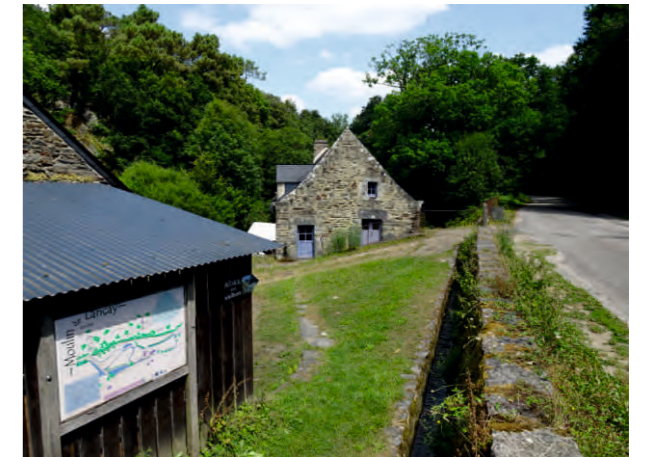
le canal d'amenée longe la route
