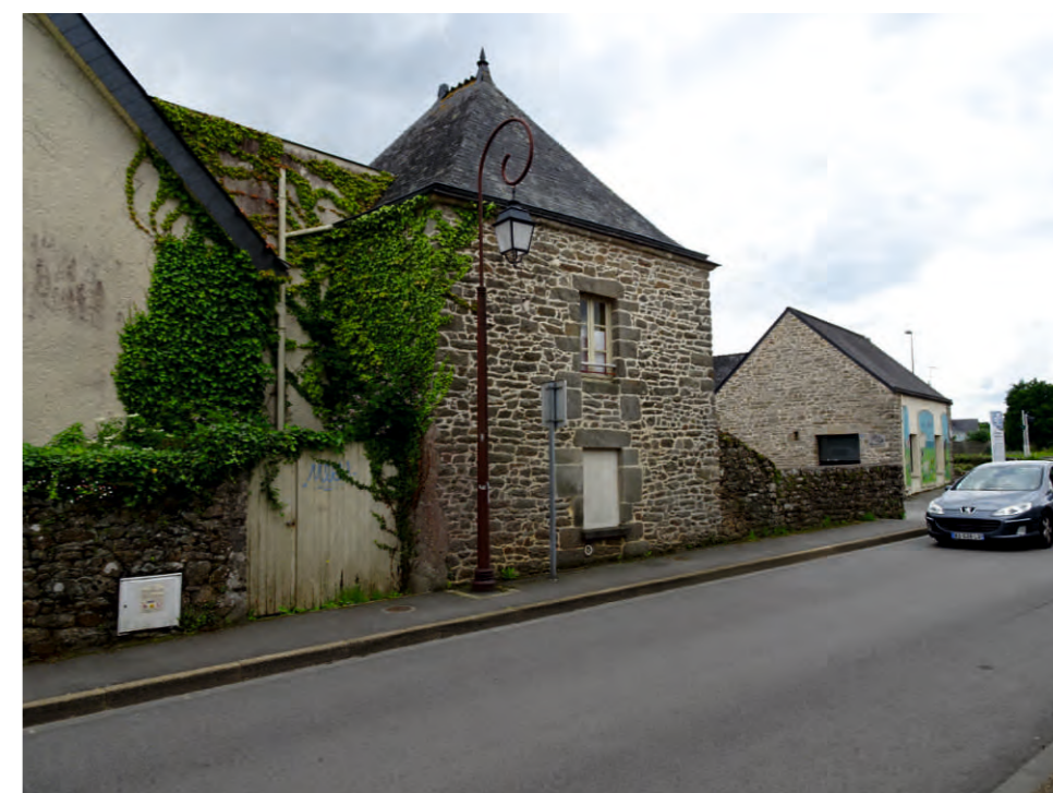
En face de la ferme des Buttes, pavillon (seconde moitié du XIX e siècle), dépendant d'un jardin disparu.
